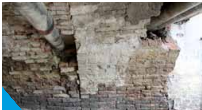
Addizione alla struttura del ponte realizzata in mattoni
