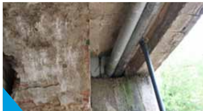
Aggiunta al ponte con soletta poggiante su trave in C.A.
